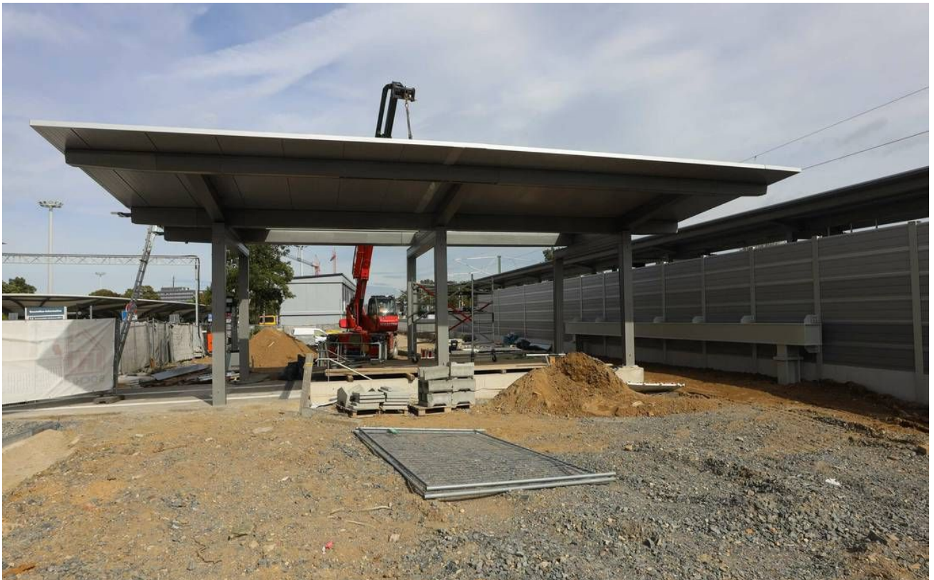
Auch der Ein-/Ausgang zur Unterführung ist überdacht.
